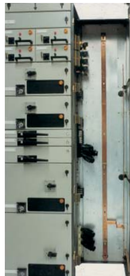
Motorschalterschrank Typ SEV 32 mit Einschüben Motor Control Centre type SEV 32 equipped with modules
